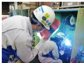
現実での溶接トレーニング
