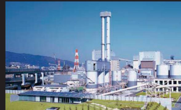
神戸製鋼所では、製鉄事業に必要な電力をまかなうために自家発電所を有しています。そのノウハウをもとに電力卸供給事業(IPP)に取り組み、2002年にはその柱となる神戸発電所の運転を開始。神戸発電所は1号機・2号機を合わせて140万kWの巨大発電所で、神戸市全体の電力消費の70%をカバーするだけの発電力をもちます。エネルギー事業部では、そんな生活に欠かせない社会インフラの整備・安定稼働をサポートしています。神戸発電所におけるボイラ、タービンなどの発電設備や、脱硫・集塵機などの環境設備の点検・修理・設備を行うほか、発電所新設に関わる付帯設備の設計・製作・工事も担い、お客様の幅広いニーズにお応えしています。
